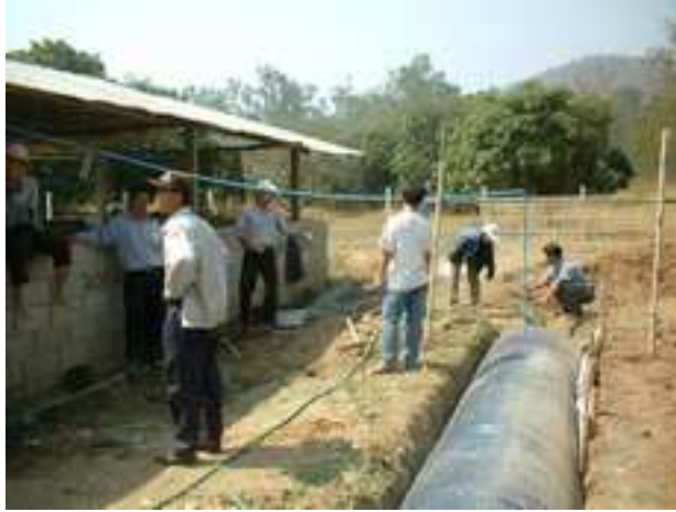
ติดตั้งท่อนำก๊าซจากถุกหมักไปยังขวระบายก๊าซ
