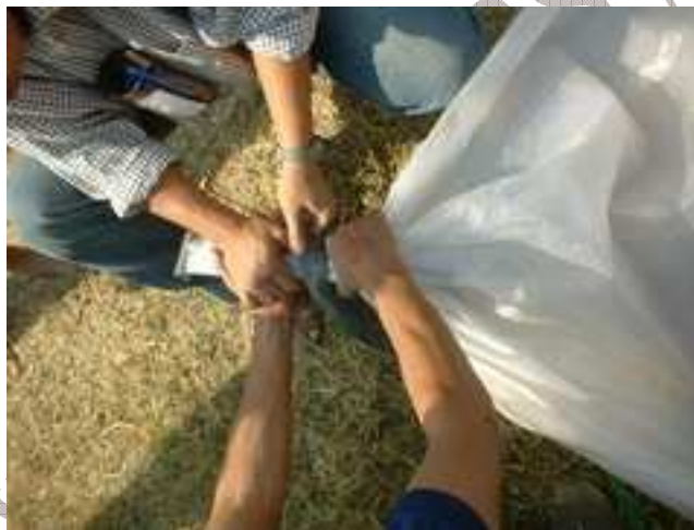
นำถุงพลาสติกอีกใบหนึ่งมัดปิดปลายข้างหนึ่งให้แน่น ส่วนปลายอีกข้างหนึ่งนำข้อต่อสามทางมาใส่แล้วมัดให้แน่นด้วยยางในรถ ถุงพลาสติกนี้จะทำหน้าที่เป็นตัวเก็บก๊าซ
