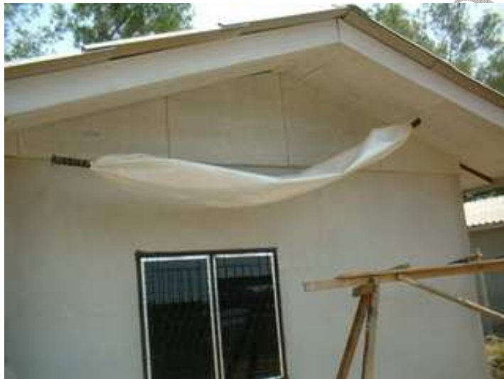
ต่อท่อนำก๊าซจากขวระบายก๊าซมายังถุกเก็บก๊าซ(ควรติดตั้งไว้ด้านบนของบ้าน)
